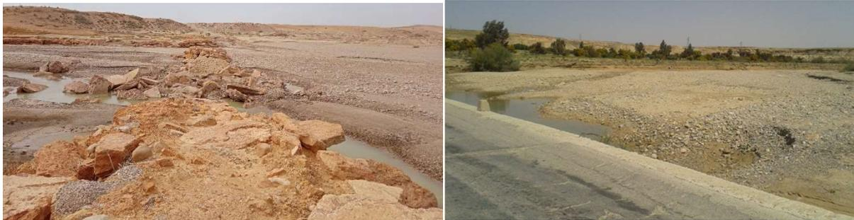
Photo 10 : le stockage des sédiments en amont des ponts et radies
