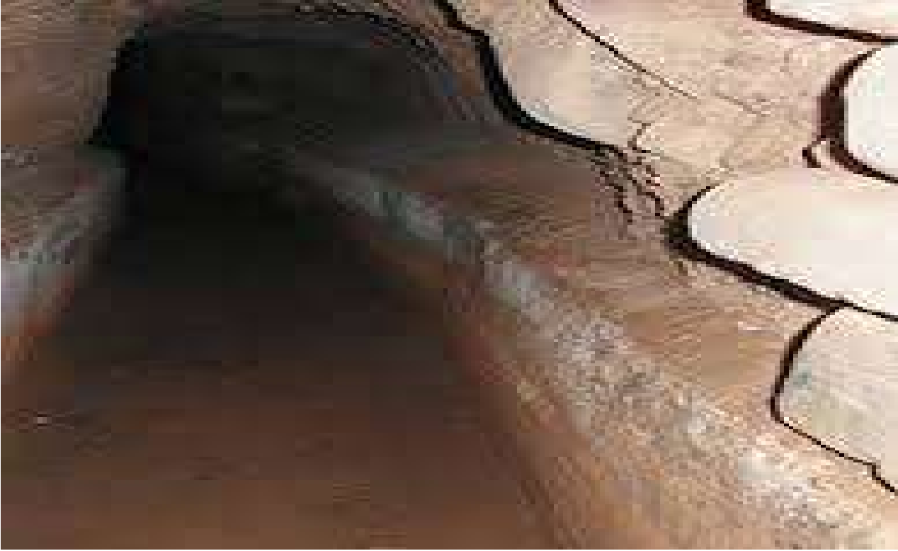
صورة انظام الخطارات التي تعتبر آية في الهندسة والتقنية المستعملة لإيصال الماء إلى الصهريج لجمع المياه
